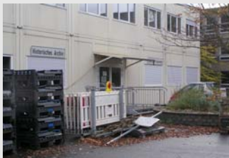
Bau- stelle: Stadt- archiv
