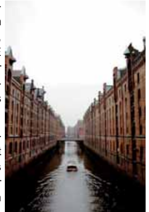
Speicherstadt Quelle: fotalia
